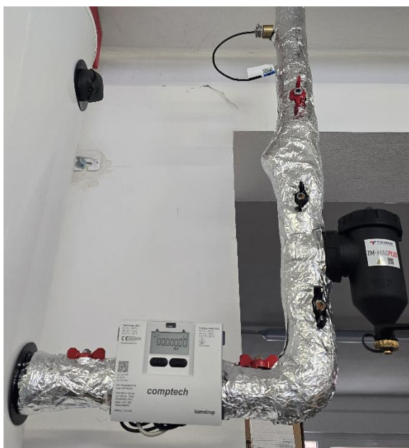
Telepített Kamstrup MULTICAL® 403 hőmennyiségmérő és OMNIPOWER villamos fogyasztásmérő összekapcsolva hőszivattyú COP mérésére
